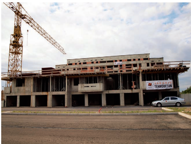
Gradilište stanova POS-a u Varaždinu
