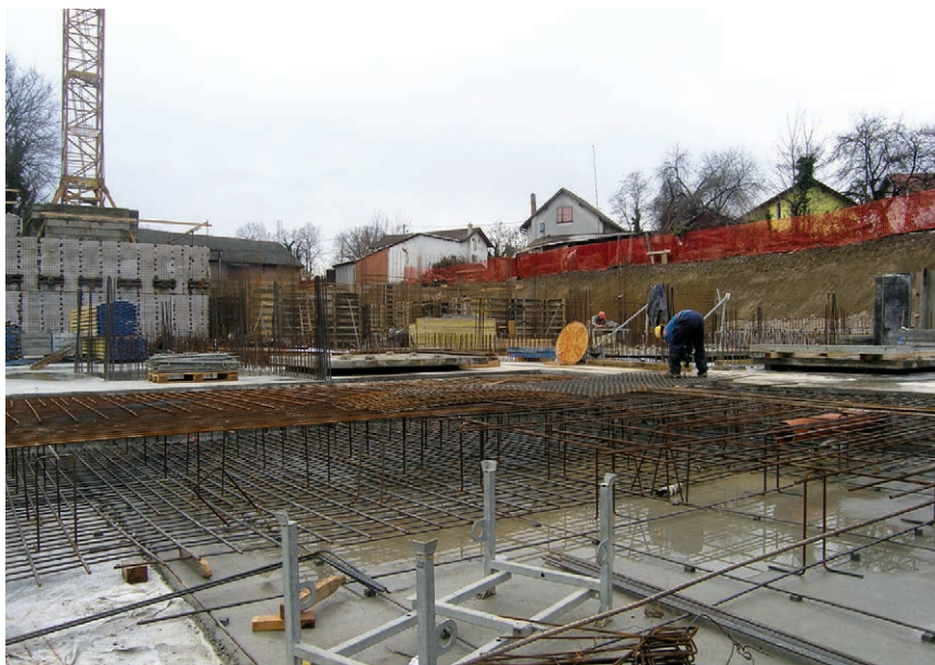
Započeli su i armiranobetonski radovi u podrumskim etažama
