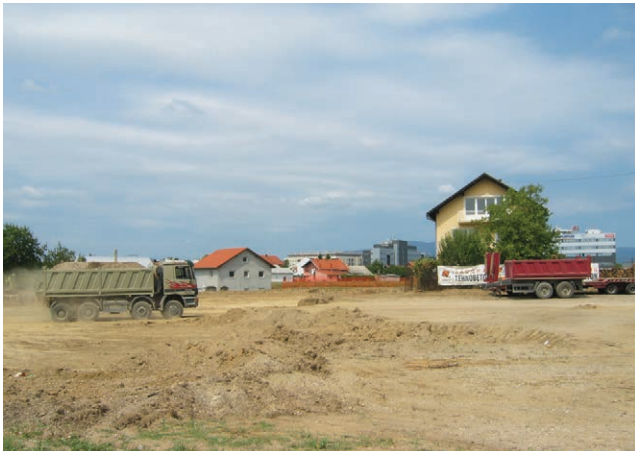
Početak radova na gradilištu u Klari
