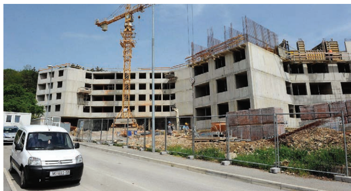
Gradilište POS-ovih stanova u Rijeci
