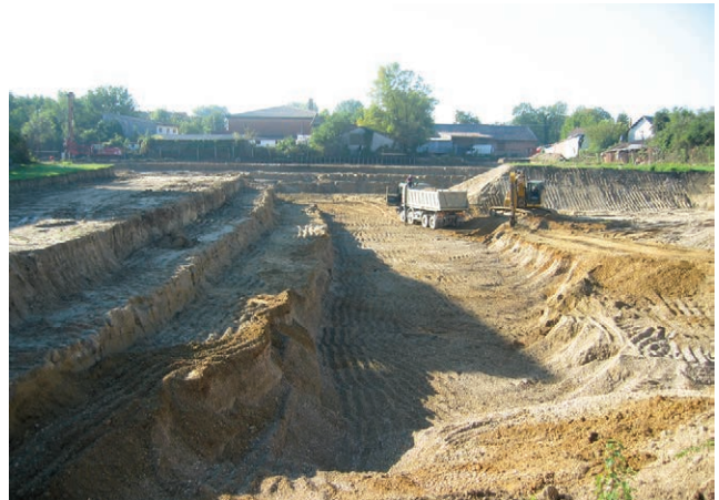
Iskopi na gradilištu
