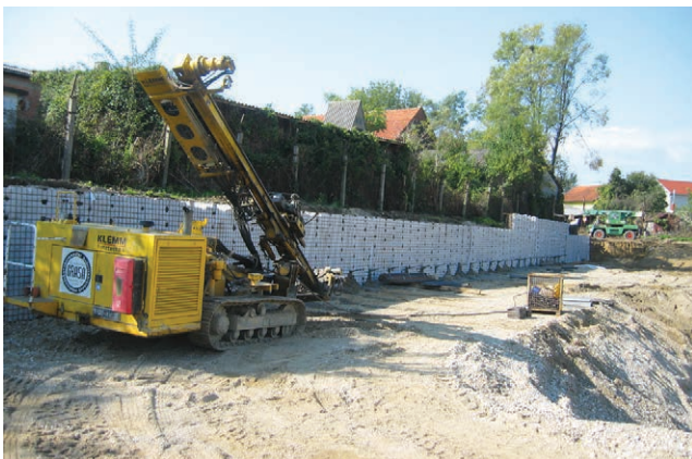
Zaštita građevne jame
