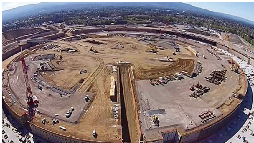
Radovi na glavnoj zgradi
