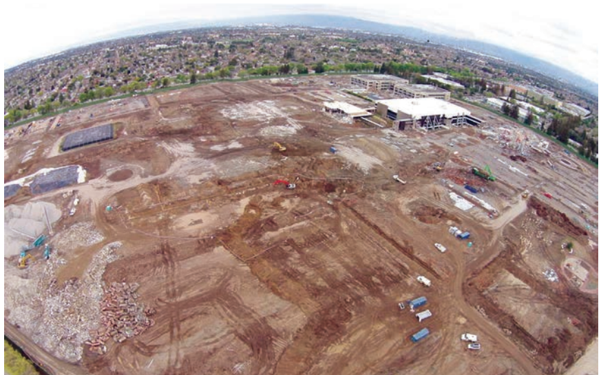
Pogled iz zraka na početku građenja
