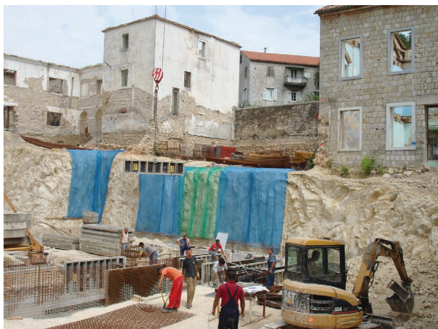
Početak armiranobetonskih radova
