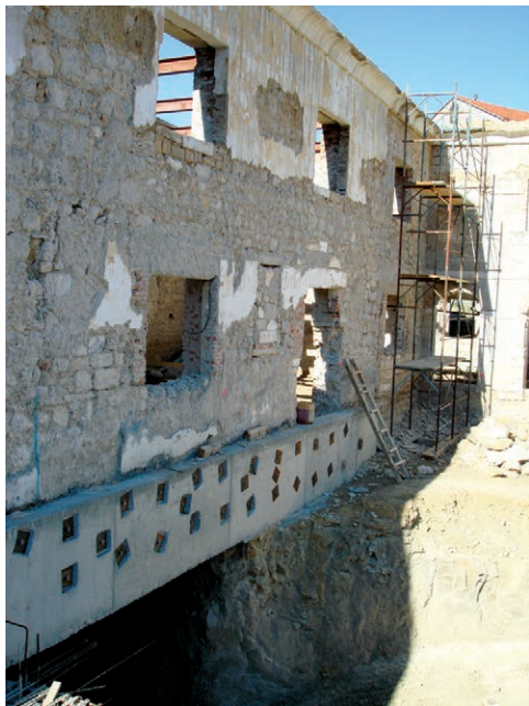
Sandučasti nosač podvučen pod temelje objekta A
