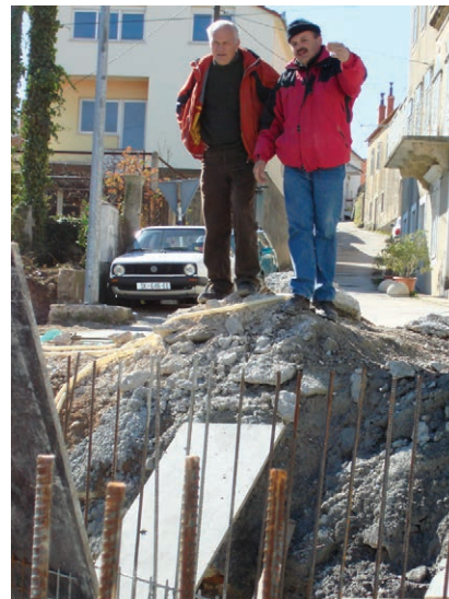
Pripreme za ugradnju vanjske infrastrukture
