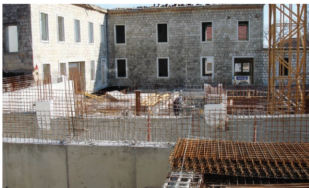
Detalj izvođenja armiranobetonskih radova
