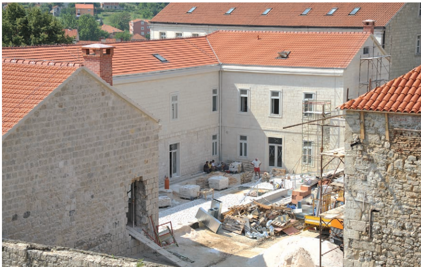
Zanatski radovi na pročeljima
