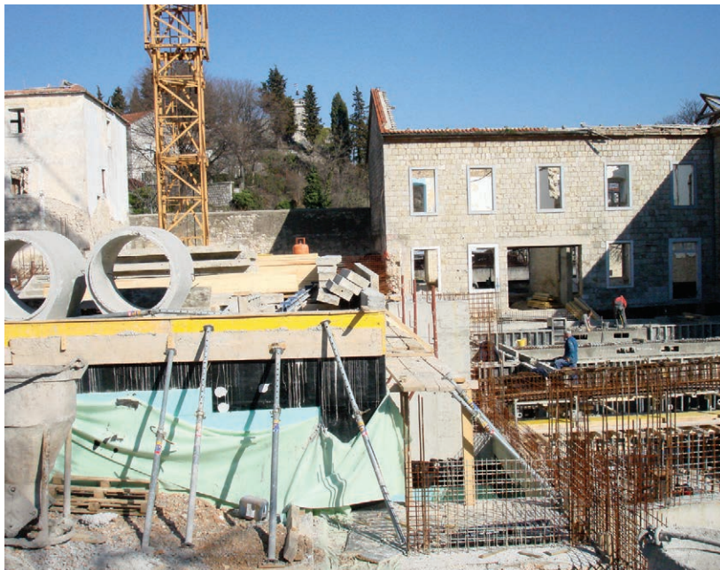
Gradnja središnjega podzemnog dijela građevine
