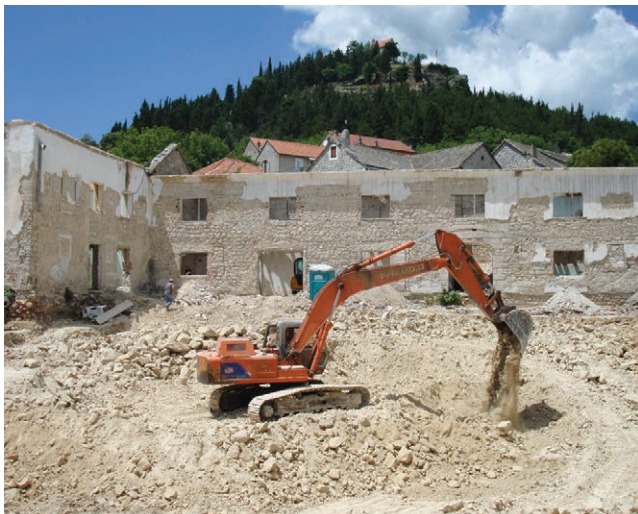
Početak širokog iskopa u dvorišnom dijelu
