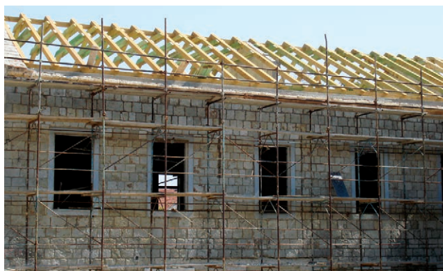
Pripreme za krovopokrivačke radove
