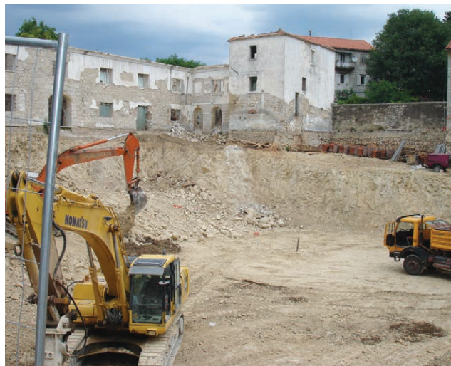
Iskop i odvoženje iskopanog materijala
