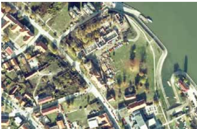
Pogled iz zraka na gradilište nakon početka radova
