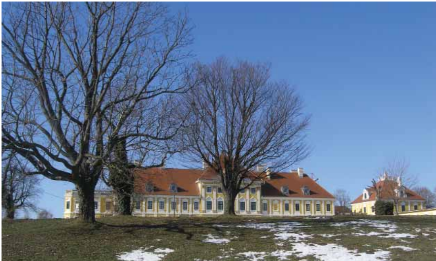
Obnovljeni dvorac Eltz (sjeverno pročelje)
