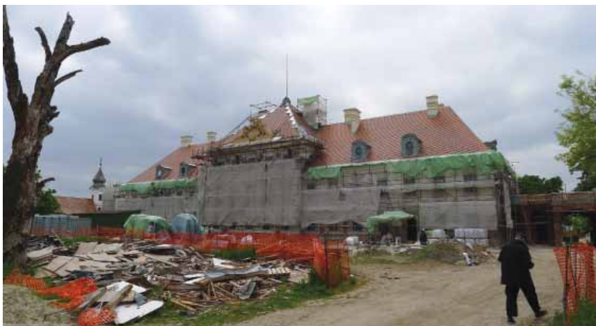
Sjeverno pročelje Velikog dvora tijekom obnove
