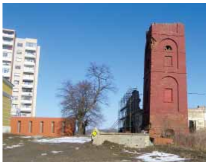
Vodotoranj i negdašnja smjemenarna uoči obnove
