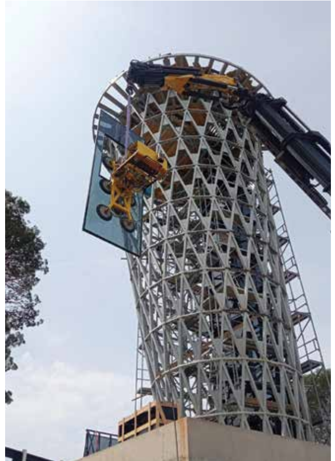
Montaža staklene fasade promatračke kuće
