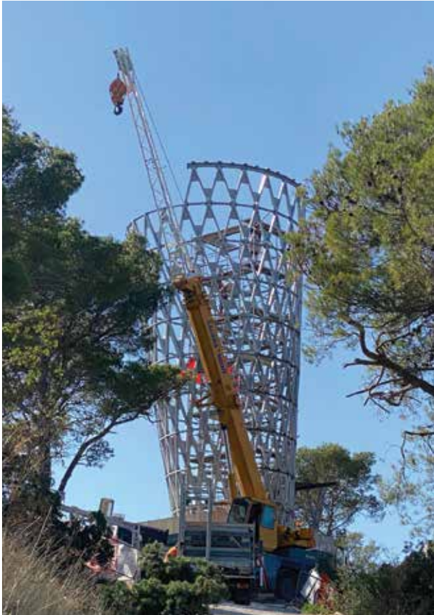
Montaža desetog čeličnog prstena
