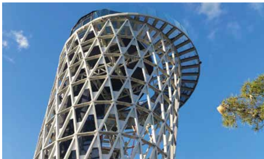
Pogled na vidikovac nakon završetka radova
