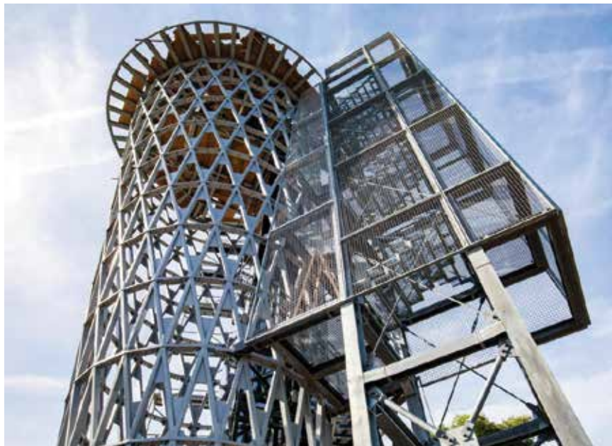
Spoj diagrida i evakuacijskog stubišta (FOTO: Vojko Bašić / CROPIX)
