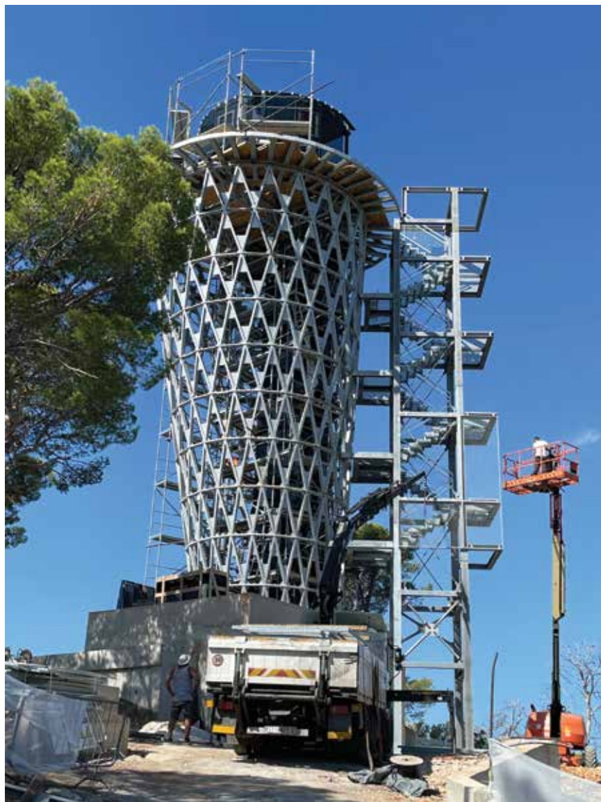
Montaža ovojnice evakuacijskog stubišta
