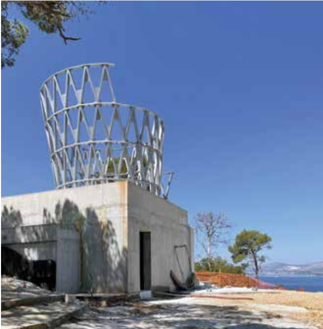
Detalji diagrida tijekom montaže
