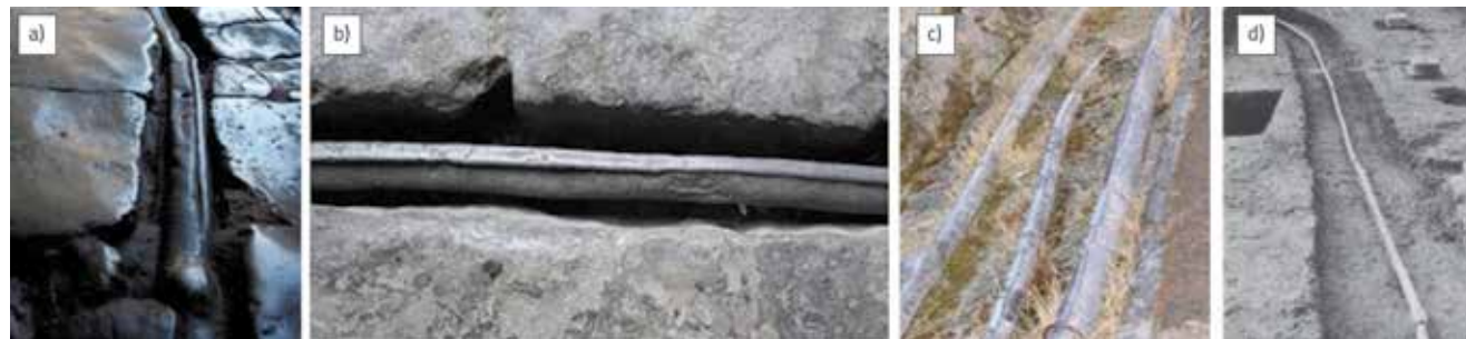
Slika 5. Primjeri polaganja cijevi u naselju
