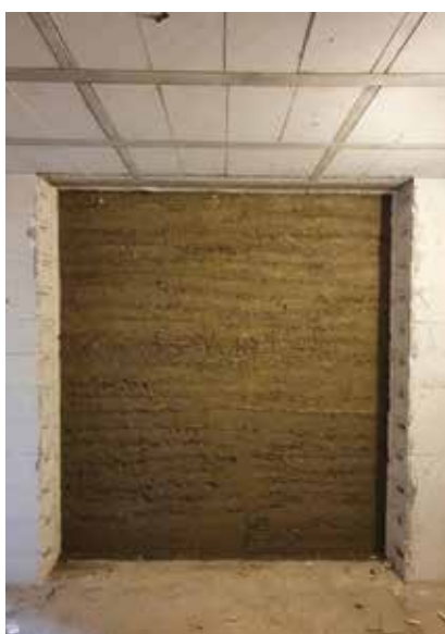
Zid uz komoru za ispitivanje zrakopropusnosti
