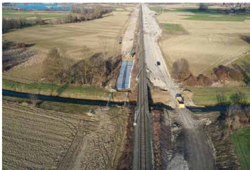
Radovi na gradilištu mosta Gliboki
