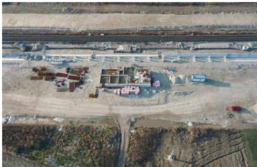
Pogled na gradilište kolodvora Novo Drnje
