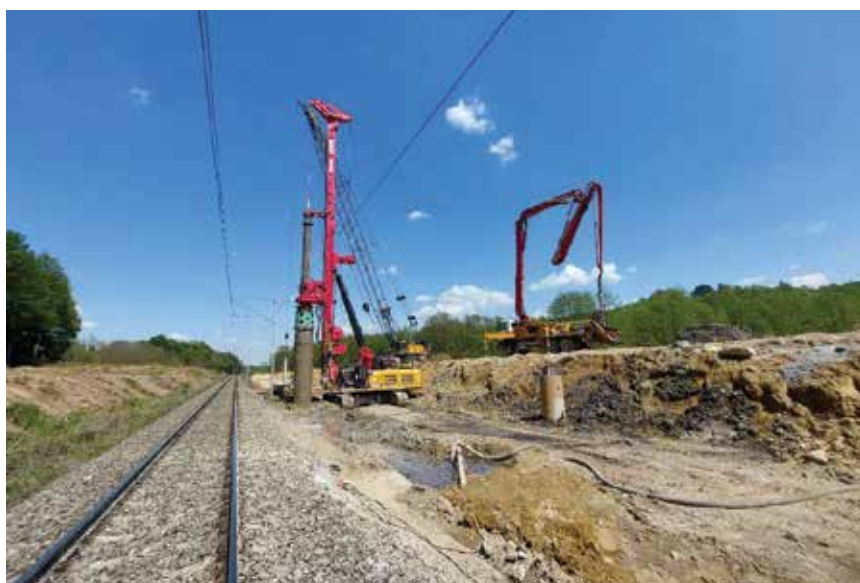
Detalj s gradilišta u Mučnoj Reki
