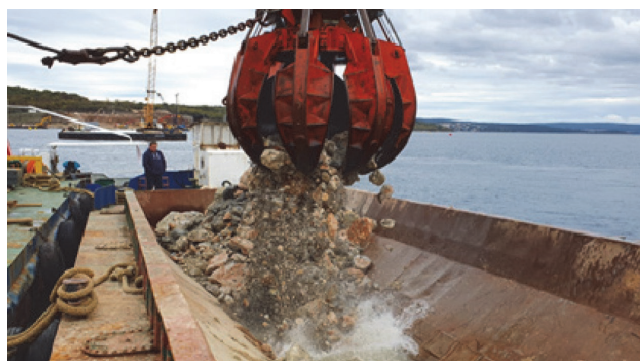
Slika 15. Utovar iskopanog materijala u klapetu [28]
