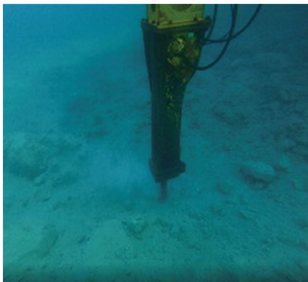
Slika 12. Iskop pomoću pneumatskog čekića [28]
