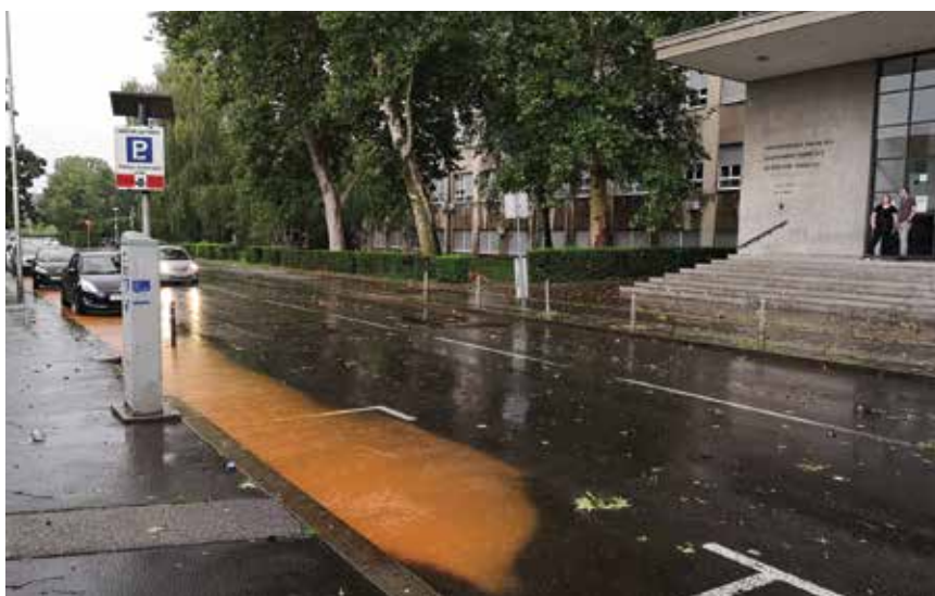
Posljedice zasipanog slivnika u Kačićevoj ulici 26 za vrijeme kišnog događaja 26. srpnja 2020. (slika Damir Bekić)
