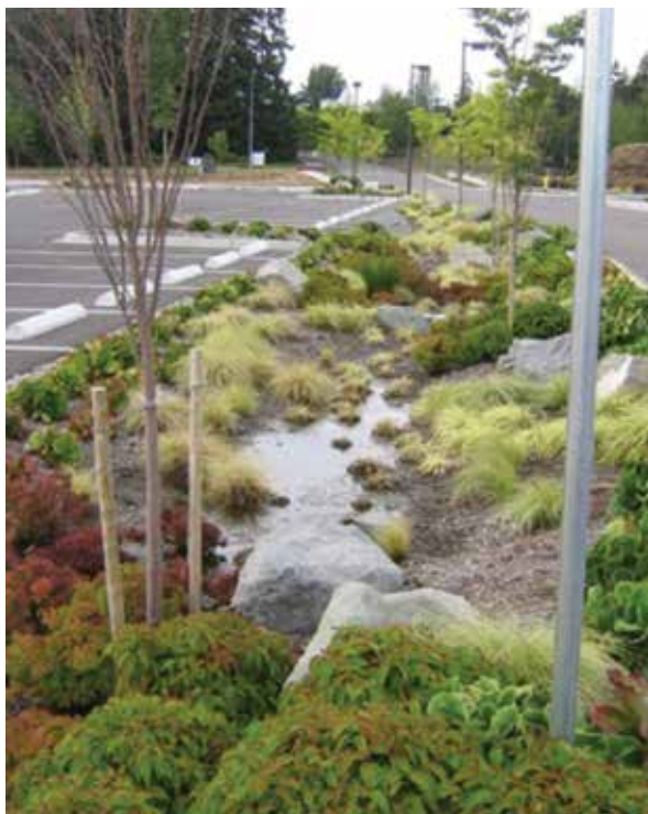
Primjer upojnih jaraka za povećanje infiltracije s čvrstih površina (izvor New Commons)
