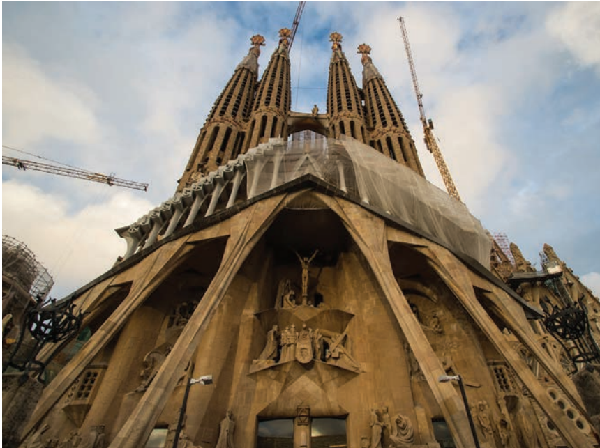
Pogled na istočno pročelje crkve
