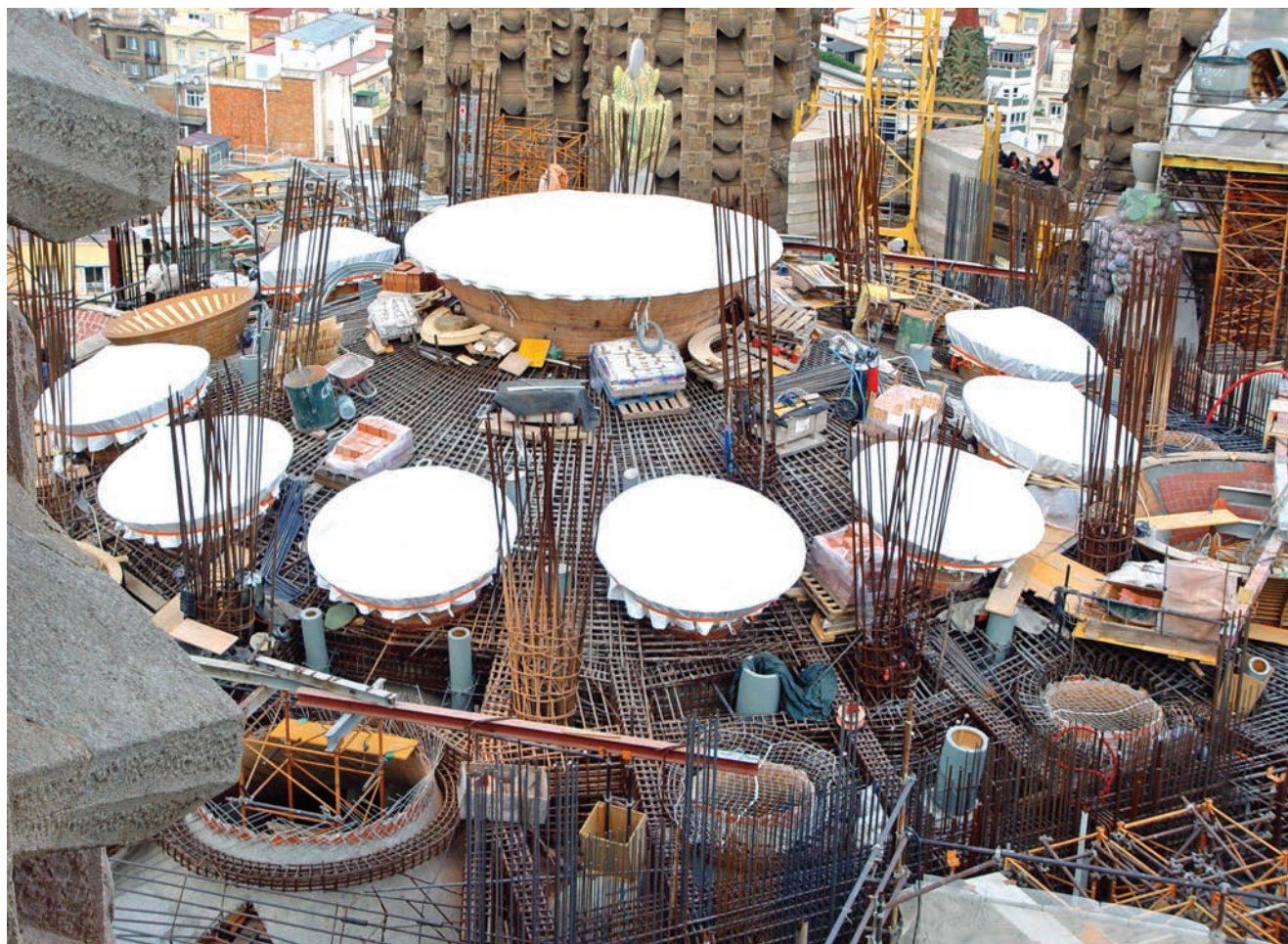
Izvedba temelja najvećeg, središnjeg tornja
