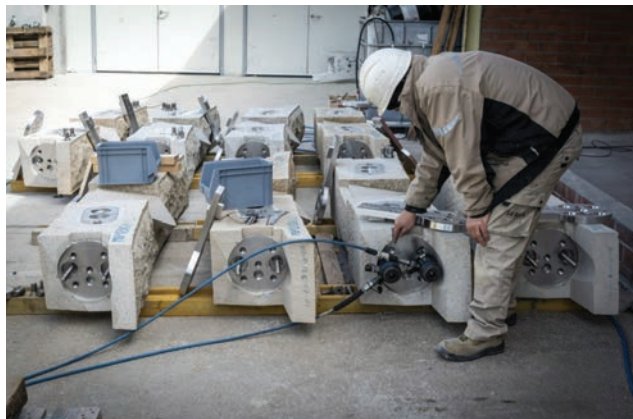
Priprema montažnih elemenata za spajanje u makro-element
