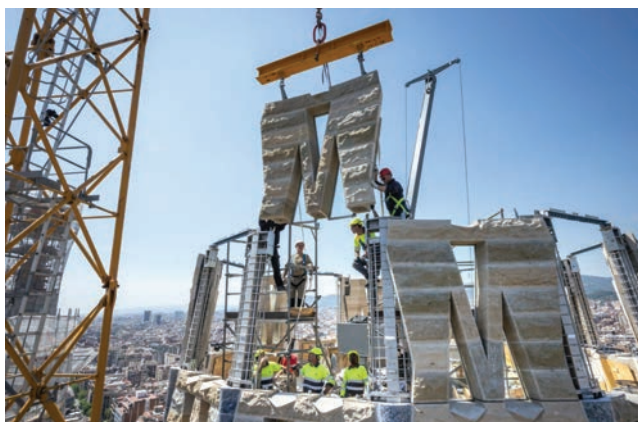
Ugradnja makroelementa na tornju, snimljeno u listopadu 2018.
