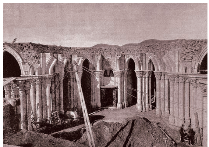
Gradilište snimljeno 1887. (Foto: PHAS UIG via Getty Images)
