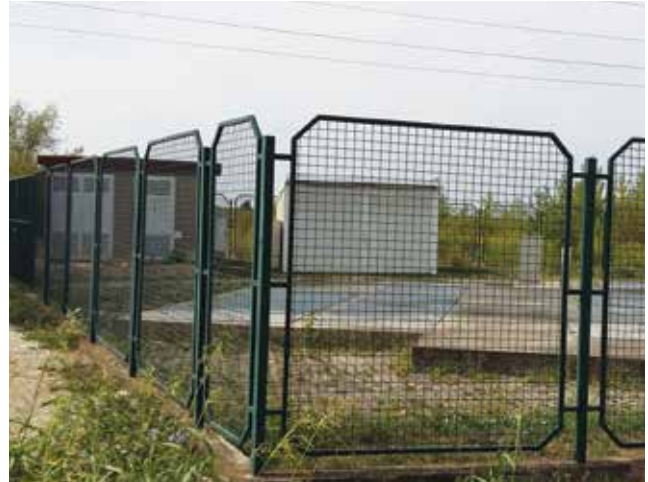
Ograđeno mjesto crpne stanice Blato
