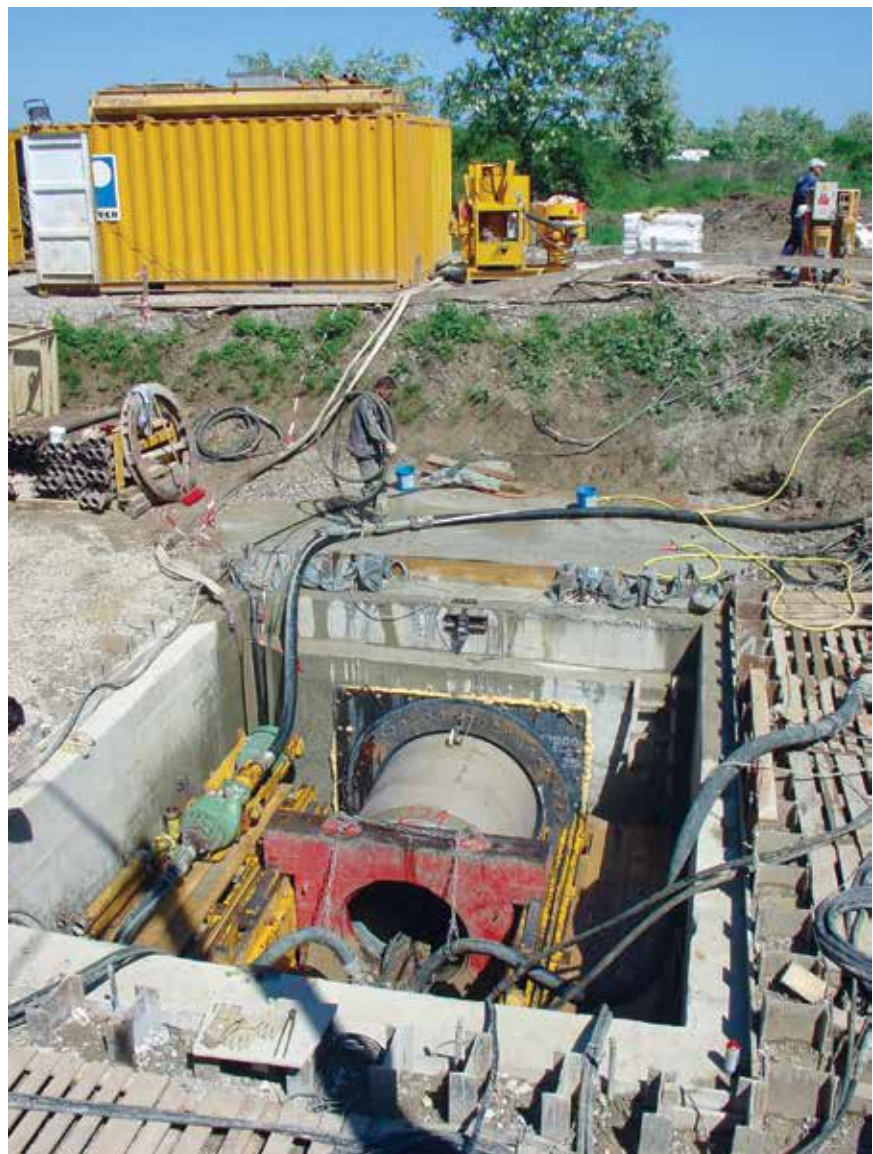
Radovi na mikrotuneliranju ispod rasteretnog kanala
