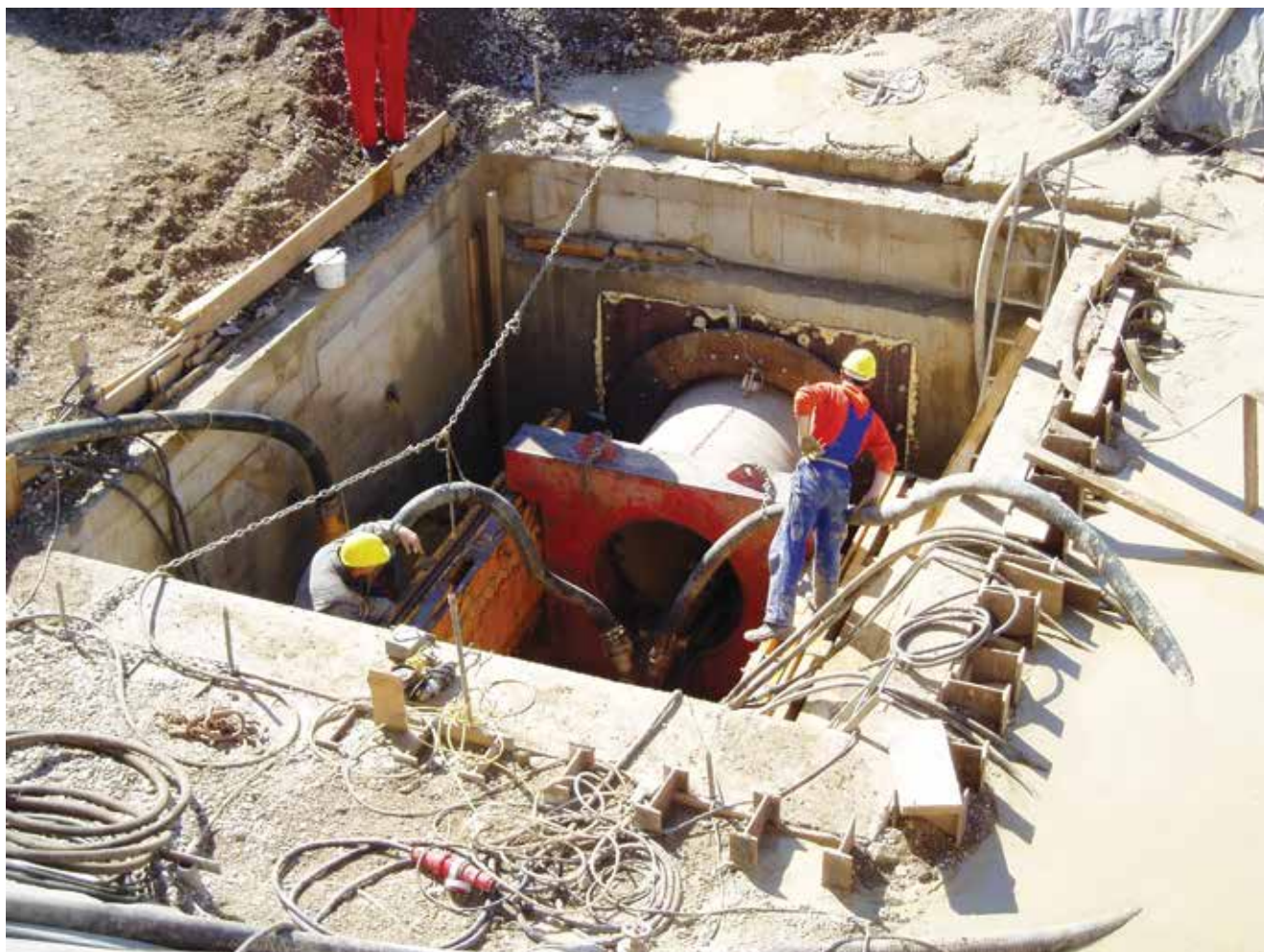
Radovi na mikrotuneliranju ispod Jadranske avenije
