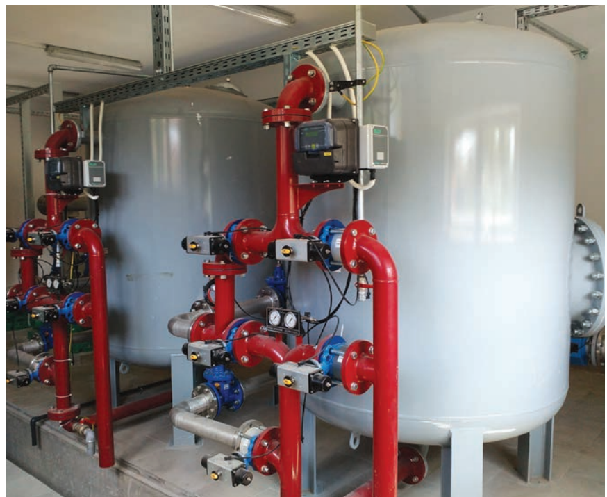
Uređaj za demanganizaciju na crpilištu Luke
