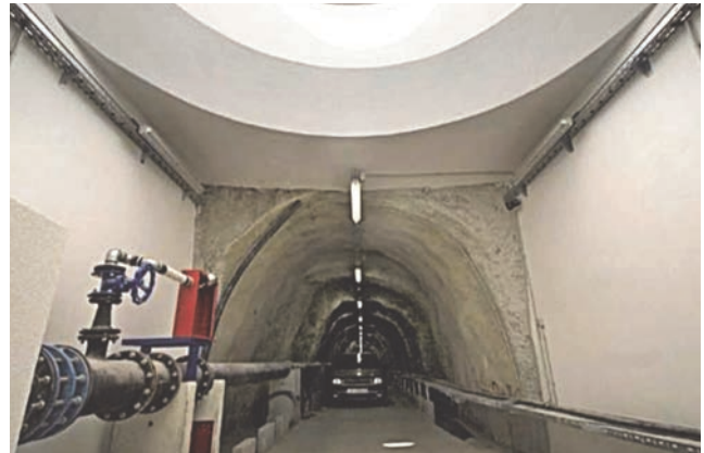
Detalj unutrašnjosti hidrotehničkog tunela Čiovo
