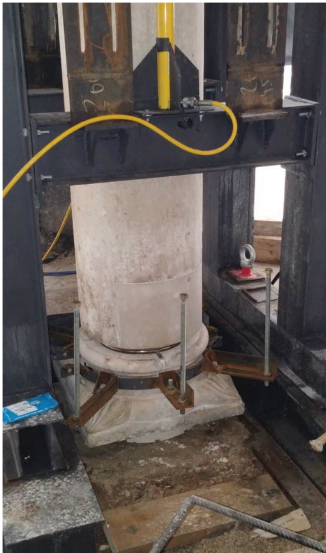
Privremeni metalni nosač koji podupire svod
