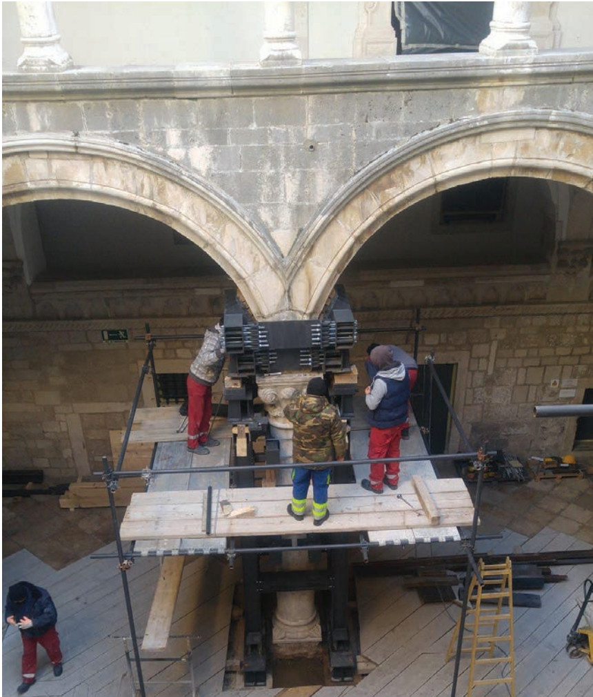
Radovi na sanaciji stupa u atriju Dvora
