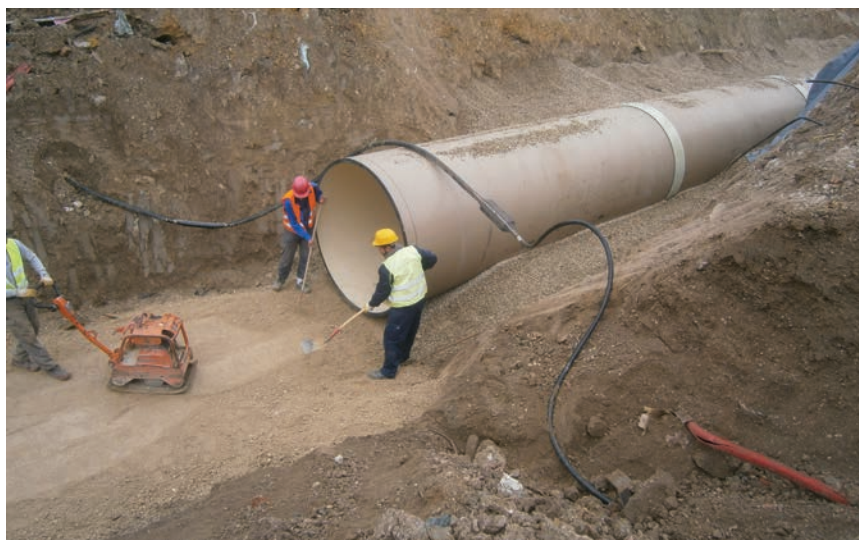
Uređenje posteljice kolektora
