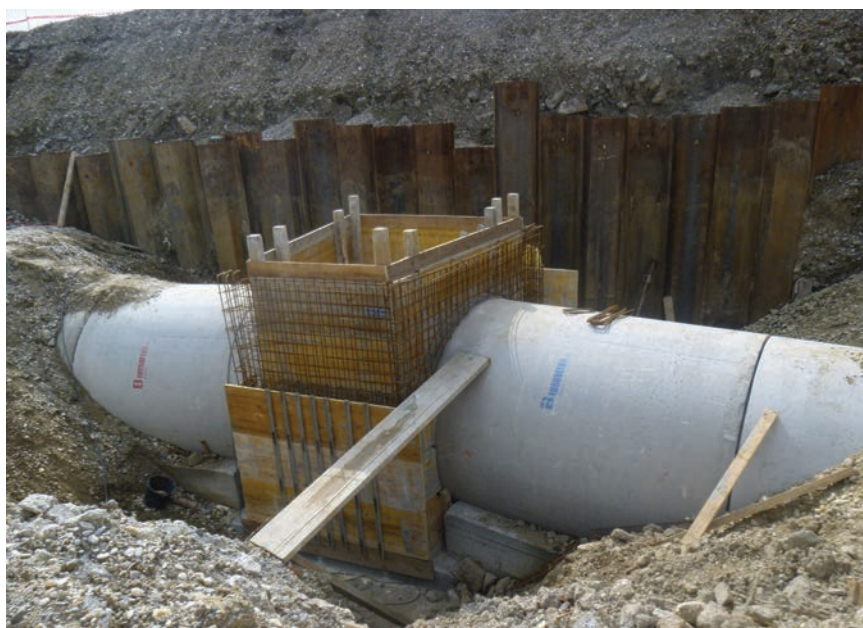
Izvođenje revizionog okna kolektora
