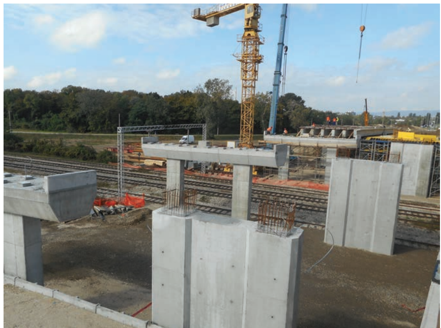
Detalj s gradilišta
