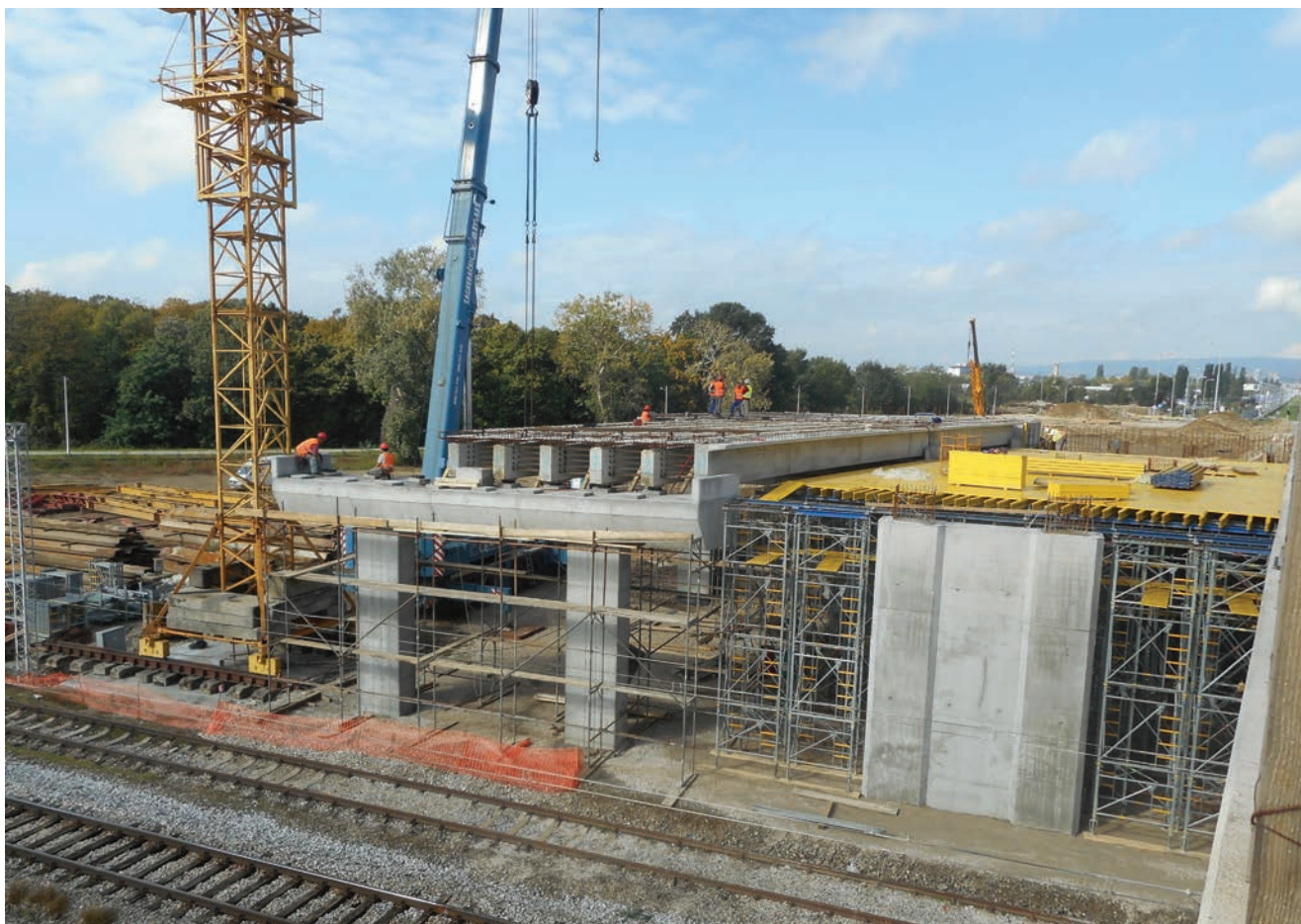
Montaža nosača desnog nadvožnjaka i skele srednjeg nadvožnjaka
