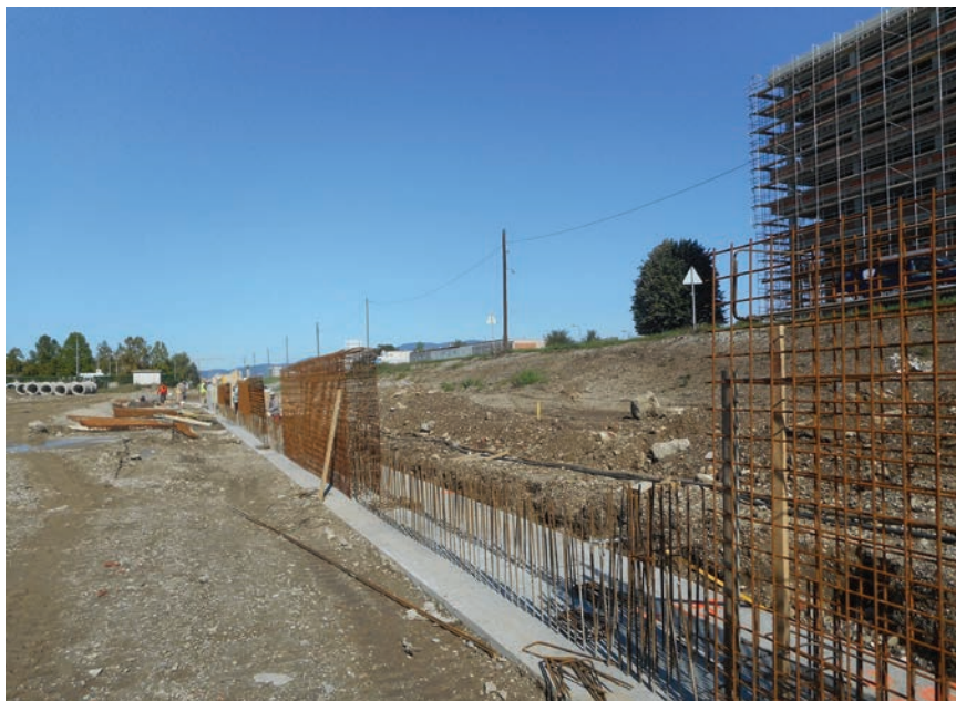
Izvođenje potpornog zida
