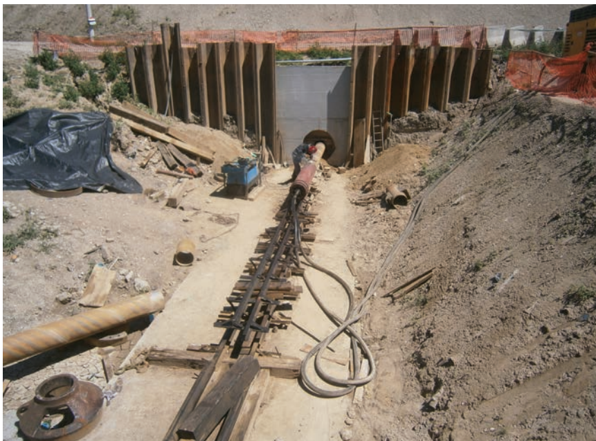
Bušenje ispod Radničke ceste za prolazak vodoopskrbnog cjevovoda
