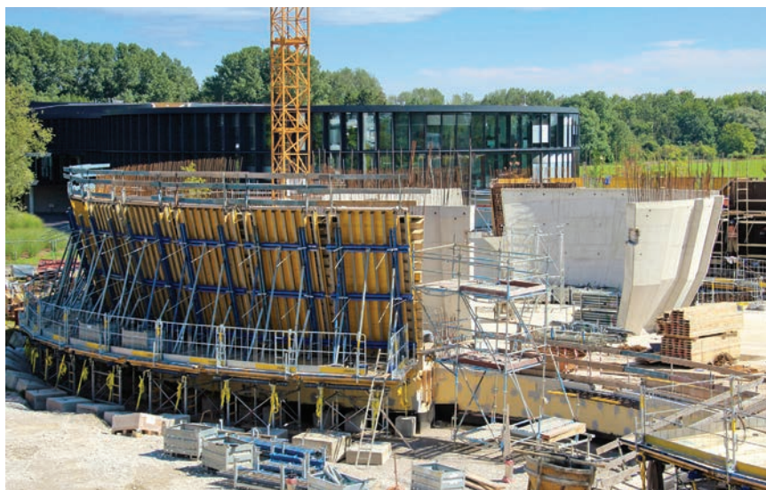
Izvođenje zidova visine 18 m, a nagibom do 23,5°
