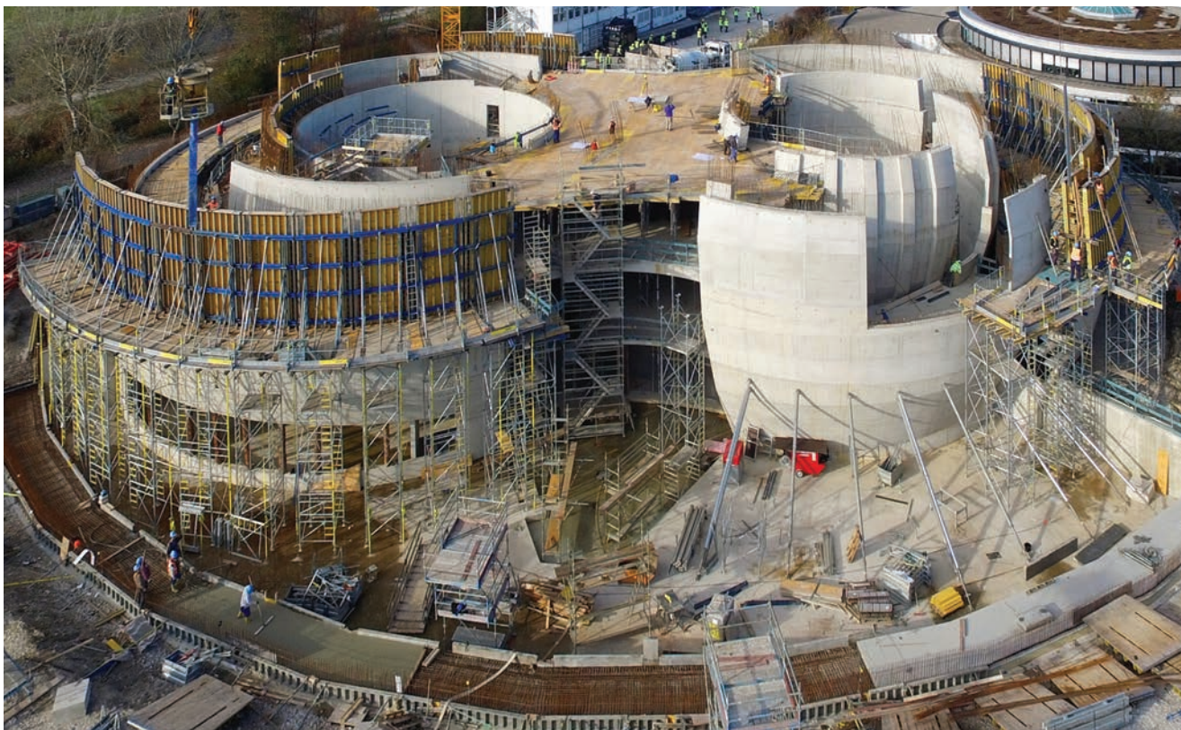
Pogleda na gradilište novog planetarija
