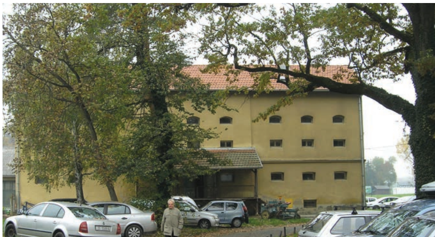
Glavno pročelje negdašnje svilane
