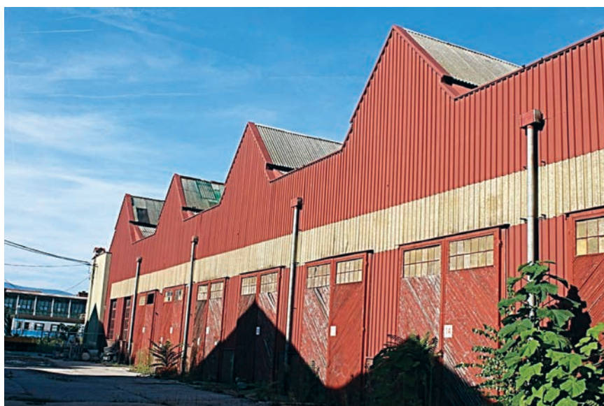
Bivši pogoni Gredelja , negdašnje Strojarnice pokraj Glavnog kolodvora
