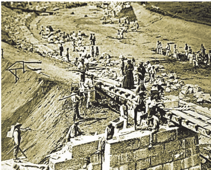
Gradnja željezničke pruge prema Rijeci pokraj Karlovca
