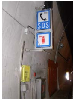
Slika 9. Novi SOS telefon i niša s PP aparatima
