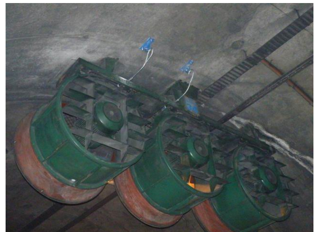
Slika 6. Grupa ventilatora s dodatnim sigurnosnim ovješnjem
