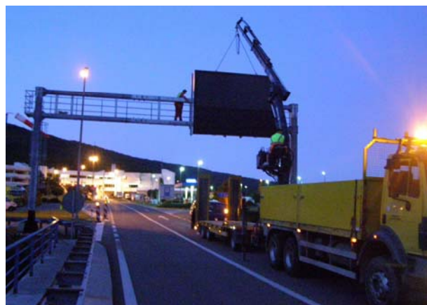
Slika 10. Montaža displeja na istarskom portalu
