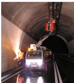
Slika 11. Radovi na 1 prometnom traku
