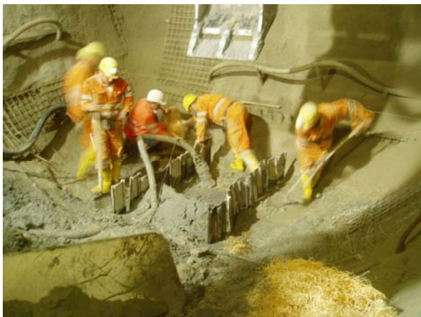
Slika 16. Vakuumske sisaljke, uzdužne i poprečne drvene pregrade
