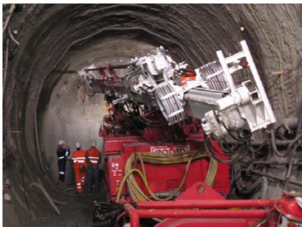
Slika 14. Jet-grouting pribor u normalnoj kolosiječnoj cijevi
