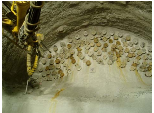
Slika 15. Hvatišta jet-grouting horizontalnih pilota
