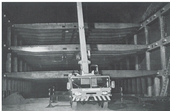
Slika 5. Ugradnja predgotovljenih elemenata
