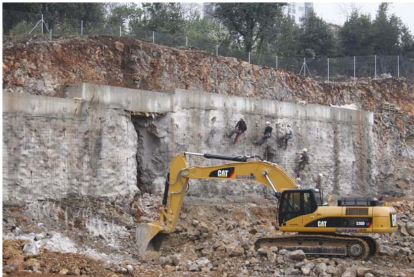
Radovi na zaštiti građevne jame
