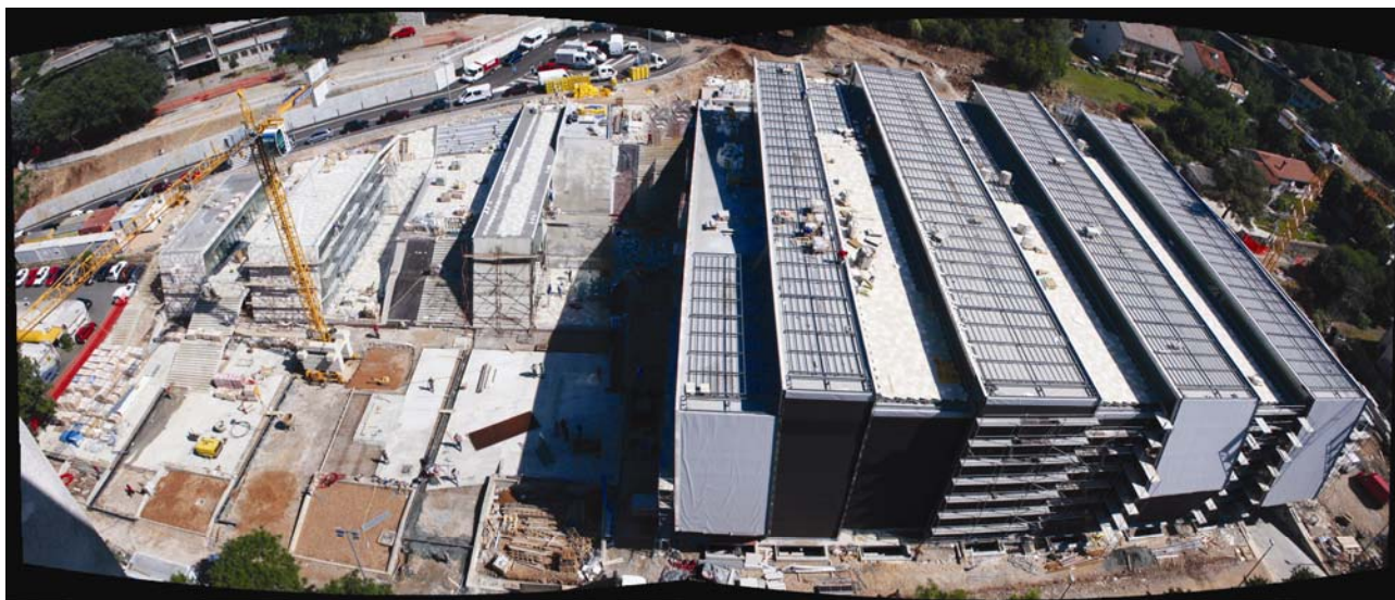
Panoramski pogled na gradilište
