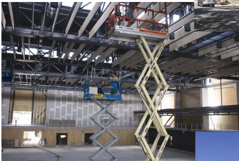
Montaža čelične konstrukcije
