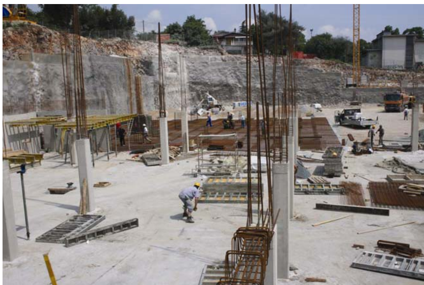
Izvedba konstrukcije iznad izvedene temeljne ploče
