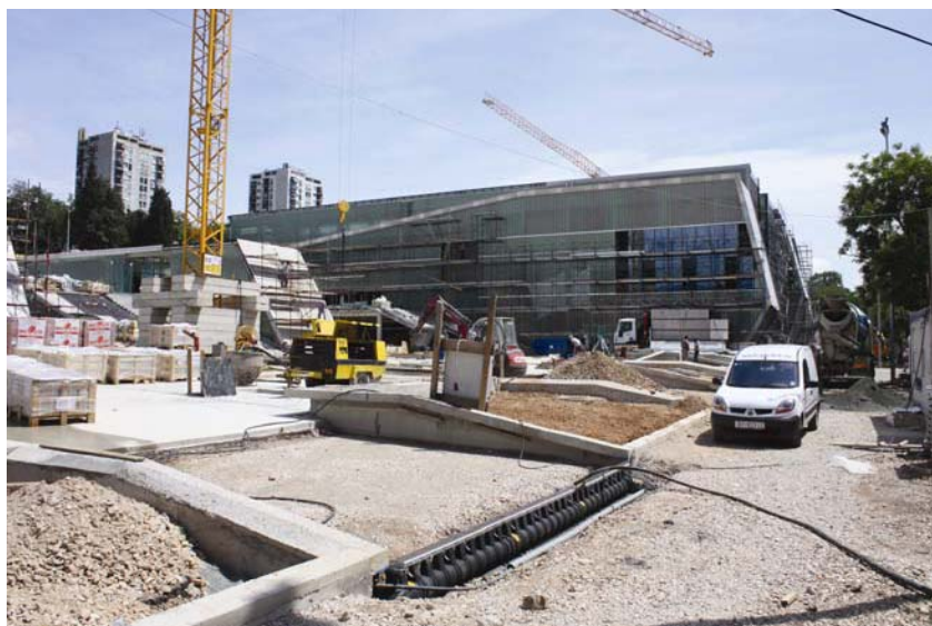
Početak uređivanja pročelja i trga
