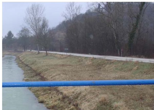
Slika 4. Nizvodni dio kanala – protok ~ 9,068 m 3 /s, vidljiv je trag vode od prijašnjeg protoka ~22 m 3 /s
