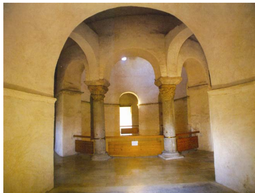
Detalj galerije (pogled iz apside prema ulazu)
