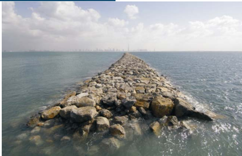
Dio izgrađenoga lukobrana
