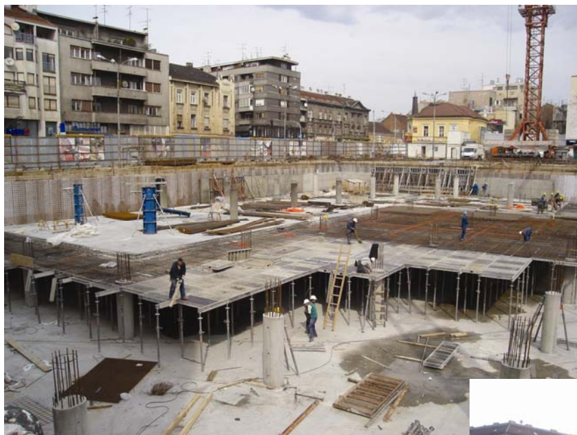
Priprema za betoniranje međukatne ploče
