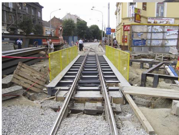
Provizorno premoštenje za tramvajsku prugu
