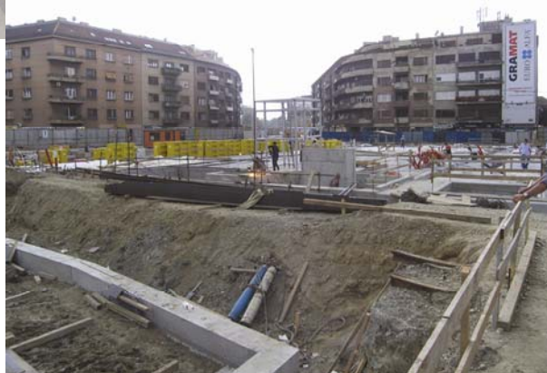
Početni radovi na gradnji pješačkog pothodnika
