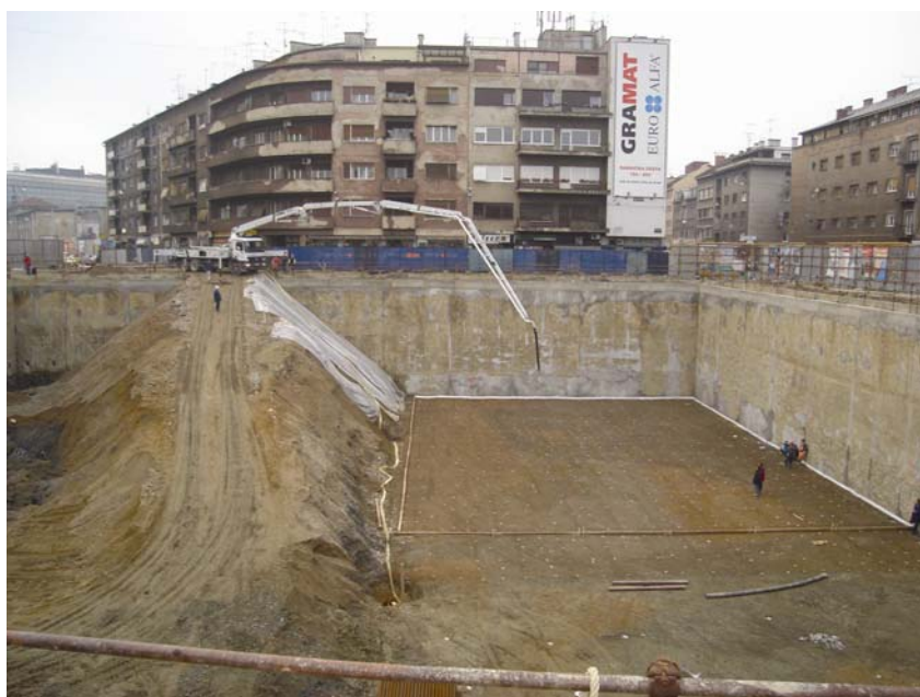
Radovi u građevnoj jami
