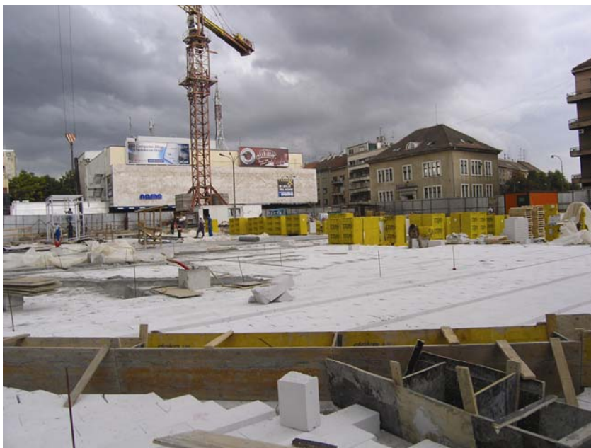
Radovi na plohi trga, zgrada Name u pozadini
