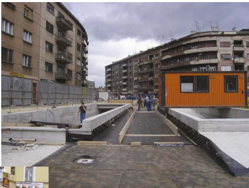
Kolni ulaz u podzemnu garažu
