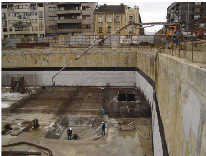
Radovi na prvoj etaži garaže
