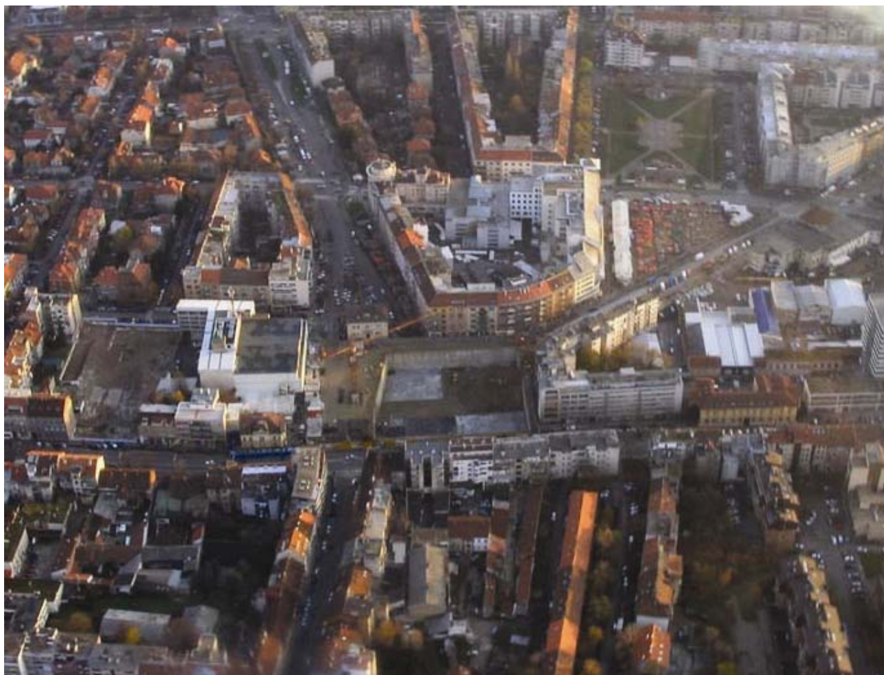
Pogled iz zraka na gradilište
