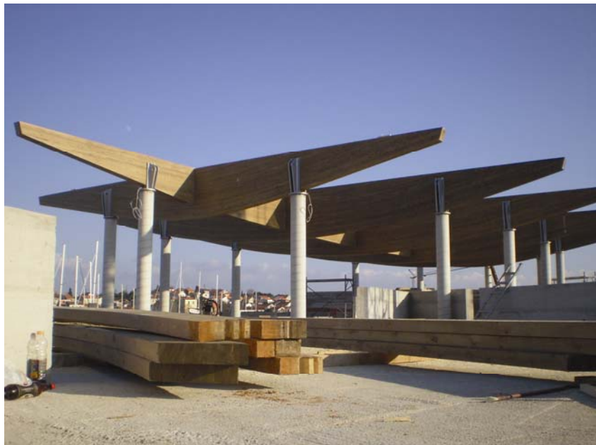
Drveni nosači krova glavne zgrade
