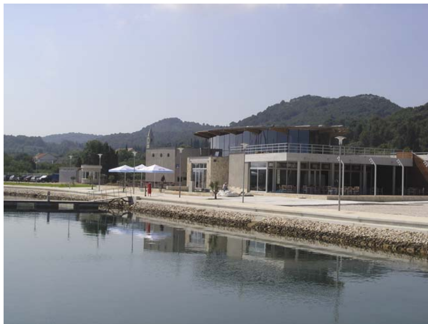
Sadašnji izgled glavne zgrade marine u Sutomiščici
