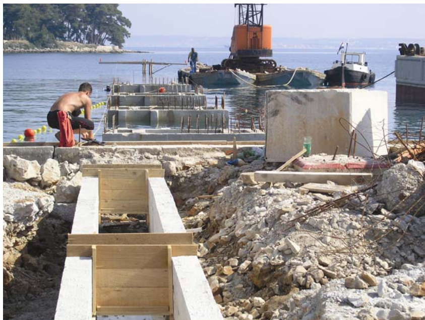
Ugradnja stupova za novi dio glavnog lukobrana
