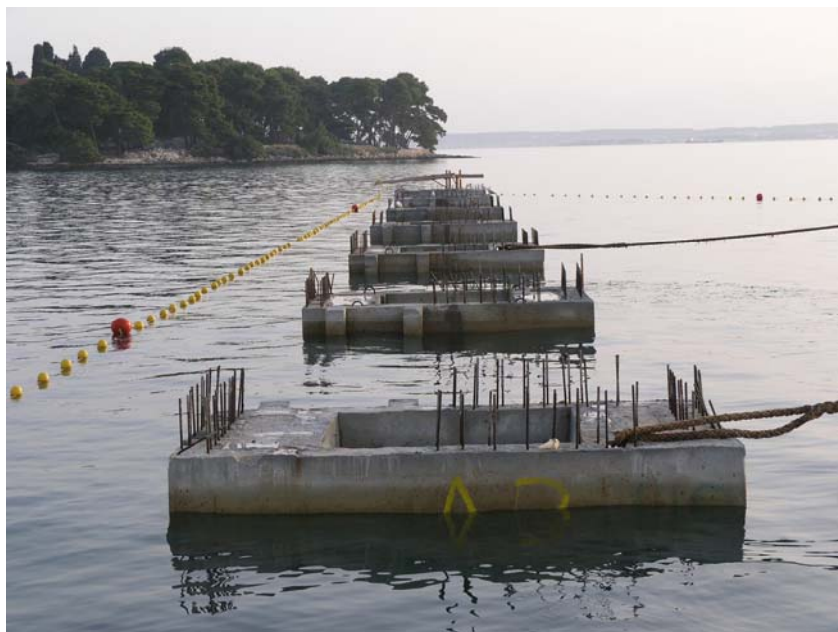
Pomorski radovi na novom dijelu lukobrana
