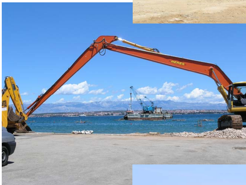
Priprema za postavljanje završnog sloja
