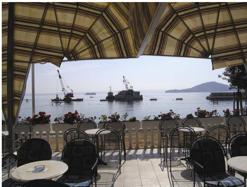
Pogled iz kafića na radove u moru
