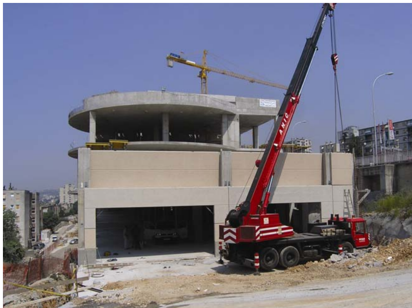
Na istočnom rubu gradilišta
