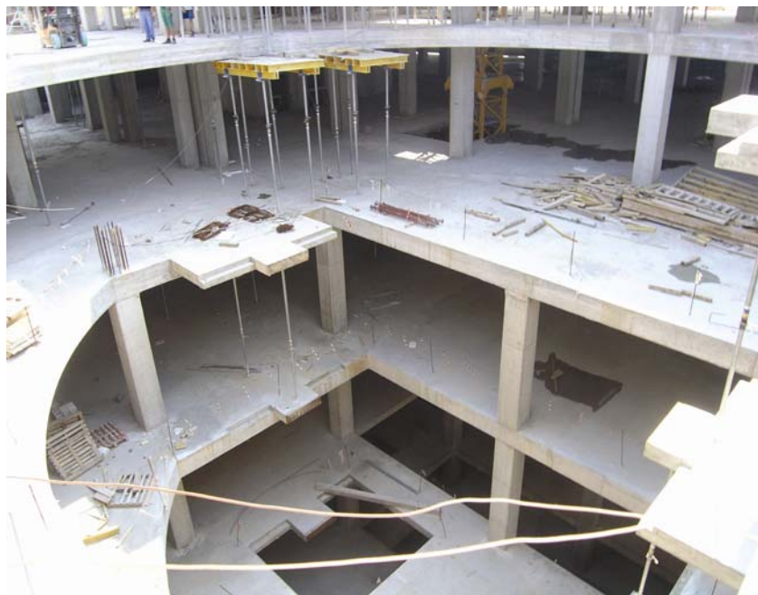
Pogled odozgo na mjesto buduće kupole
