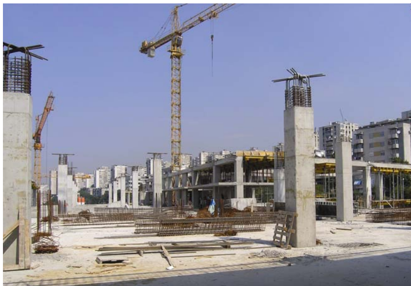
Radovi na krovu nadzemnog dijela
