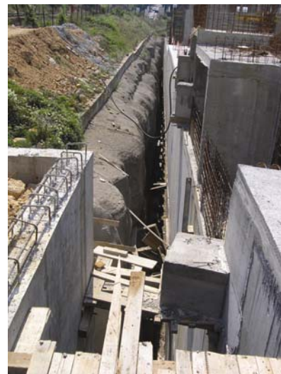
Izvođenje potpornog zida uz željezničku prugu
