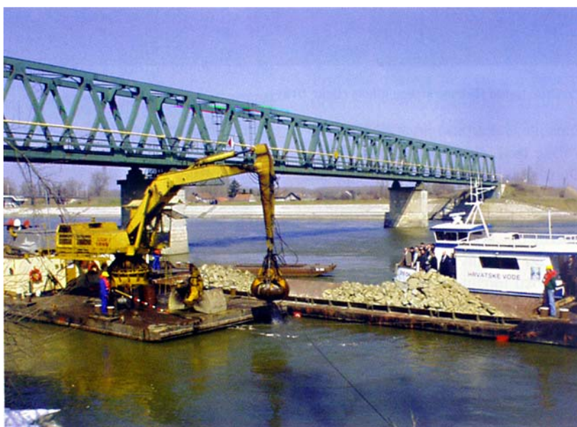
Saniranje i stabiliziranje obale Drave u Osijeku
