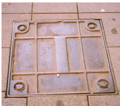
Zaključani poklopac na nogostupu Jurišićeve ulice u Zagrebu
