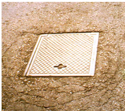
Poklopac revizijskog okna u Zagrebu koji se otvara, a ne vadi
