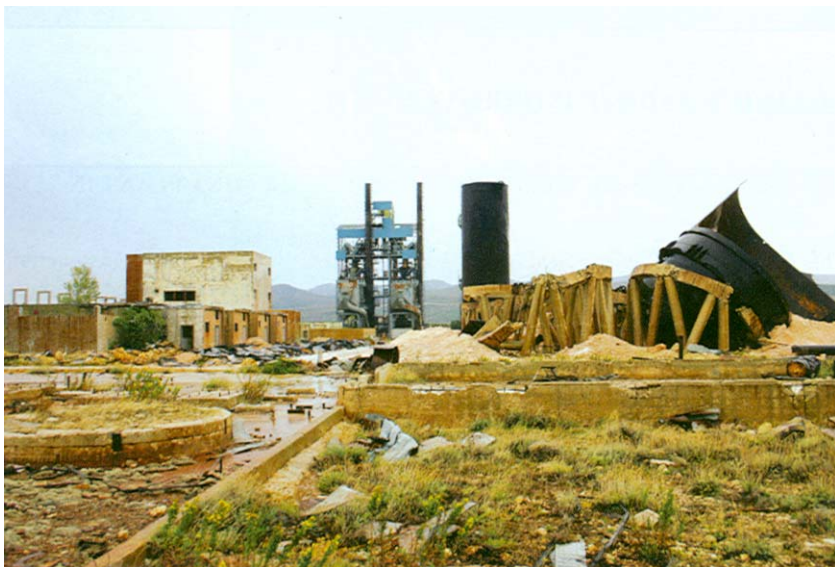
Dio potpuno devastirane bivše tvornice
