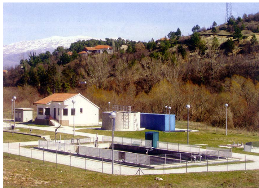
Pogled na uređaj za pročišćavanje u Trilju
