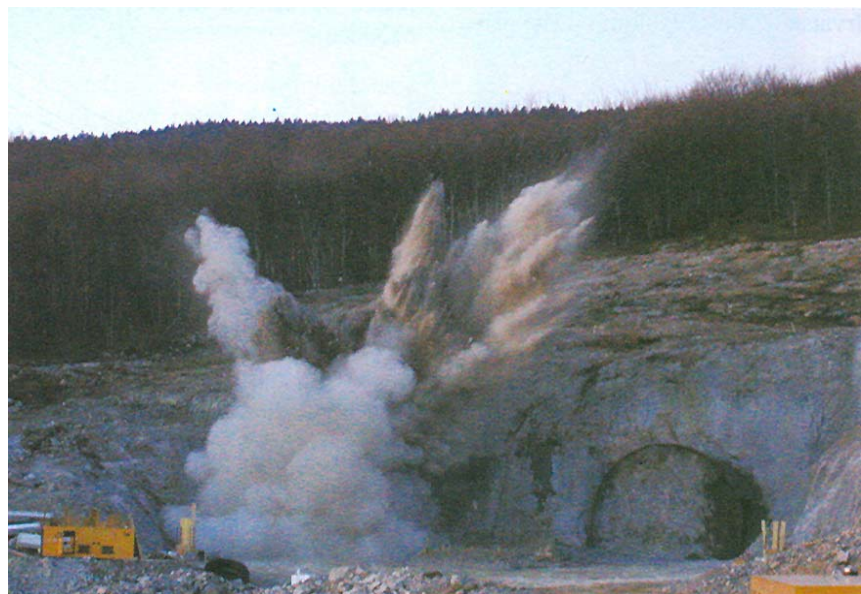
Prva miniranja na sjevernom ulazu u tunel
