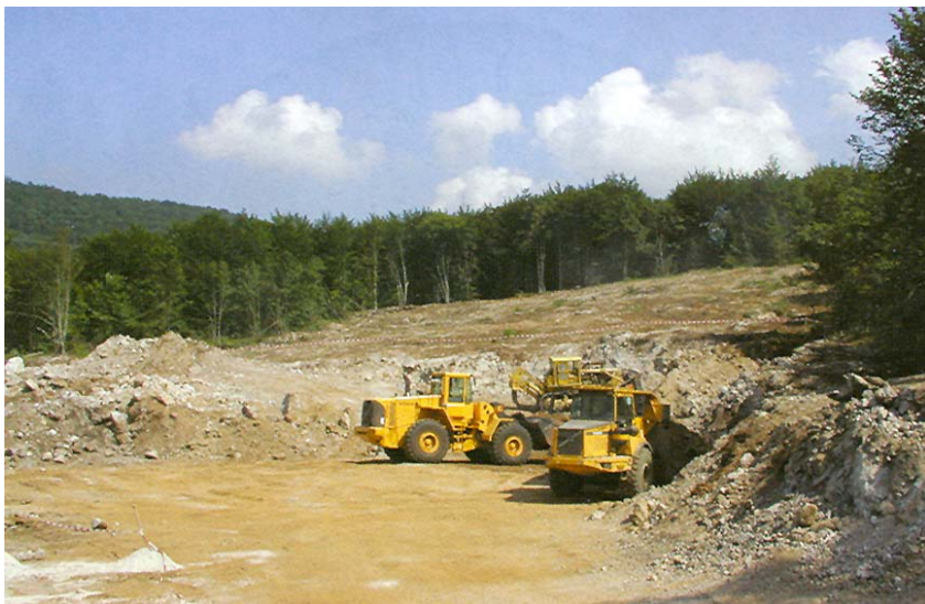
Početak radova na južnoj strani tunela
