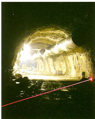
Laserska zraka za određivanje linije iskopa
