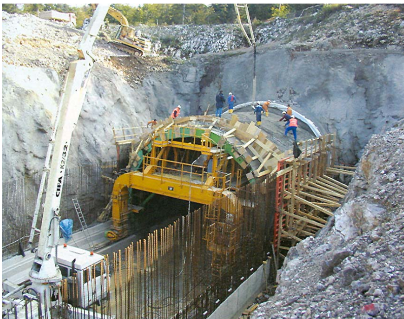
Betoniranje natkrivenog dijela tunela na sjevernoj strani
