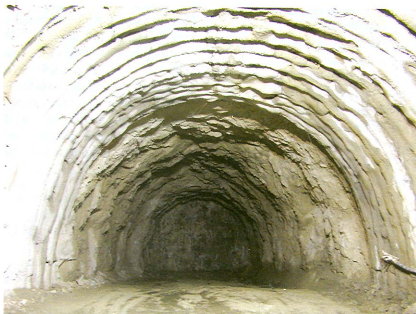
Iskopani dio tunela s primarnom podgradom
