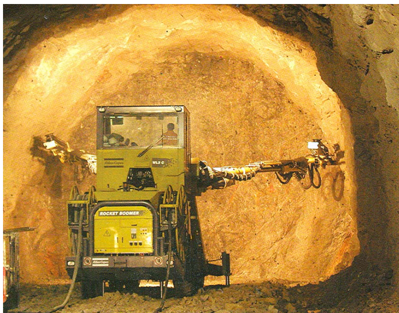
Priprema za miniranje u jednoj cijevi iskopa
