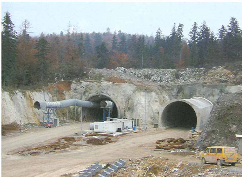
Dovršavanje portalnih građevina na sjevernom ulazu u tunel
