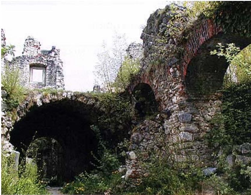
Ostaci svodova i pregrada
