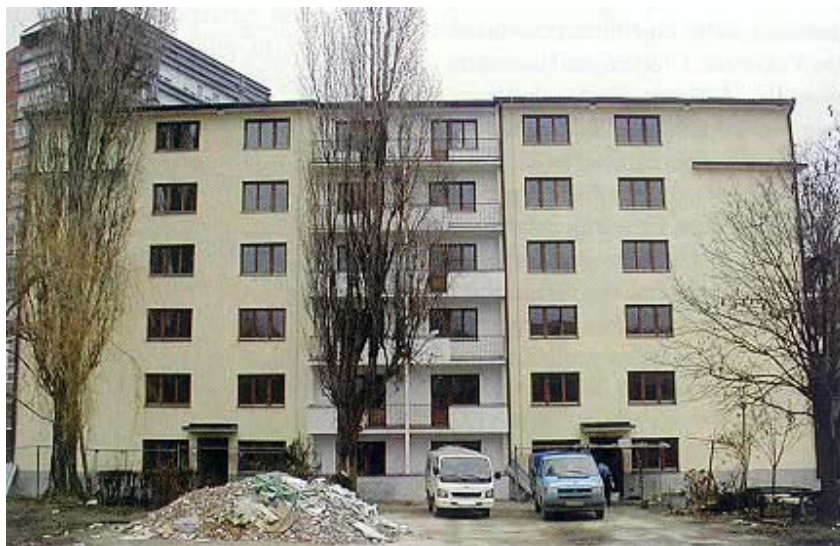
Zgrada u Ulici kralja Zvonimira 78, 80 u Borovu naselju pred završetkom obnove
