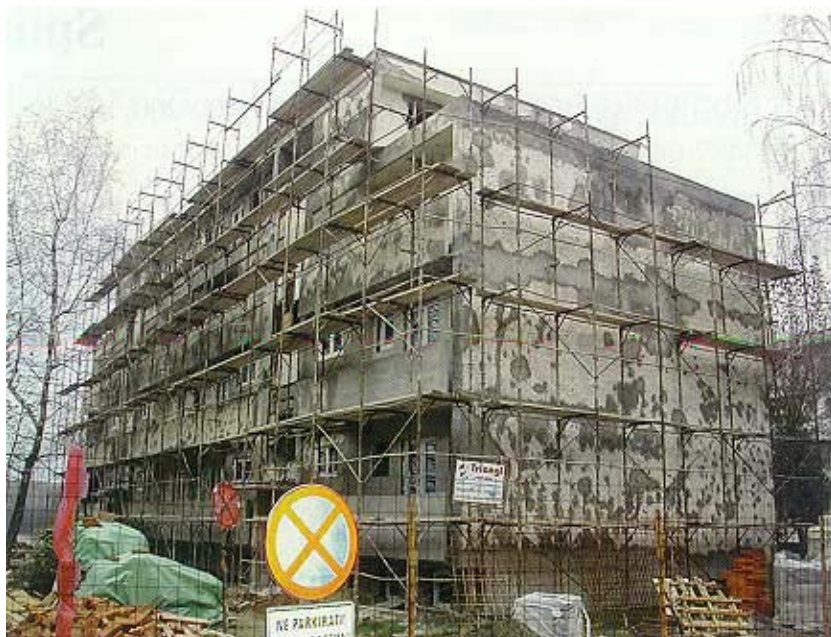
Obnova zgrade u Županijskog ulici 124. 126 u Vukovaru
