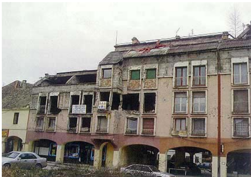
Zgrada u Nazorovoj 1 u Vukovaru uoči obnove
