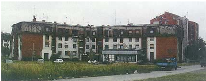
Sklop zgrada u Borovu naselju popularno zvan "Banane" gdje obnova još nije započela
