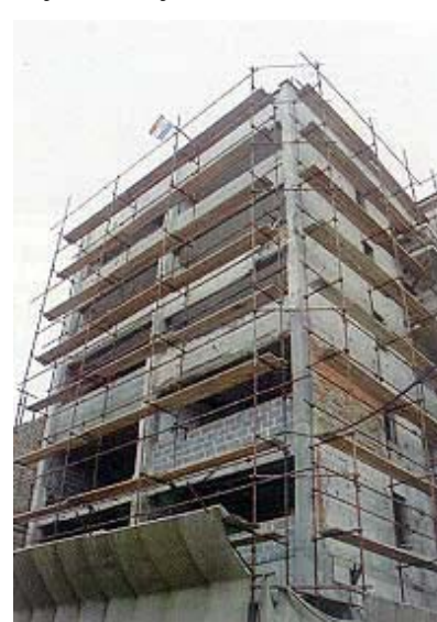
Zgrada u Nazorovoj 11 u obnovi
