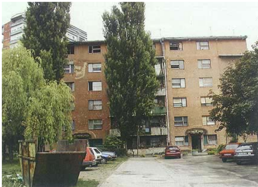
Zgrada u Ulici kralja Zvonimira 78, 80 u Borovu naselju prije obnove
