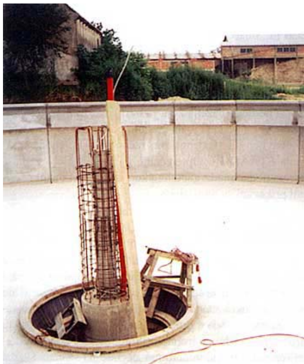
Slika 4. Detalj taložnika tijekom gradnje
