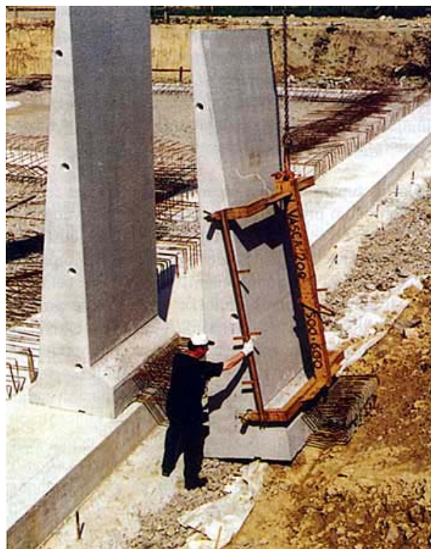
Slika 2. Zidni paneli tijekom montaže
