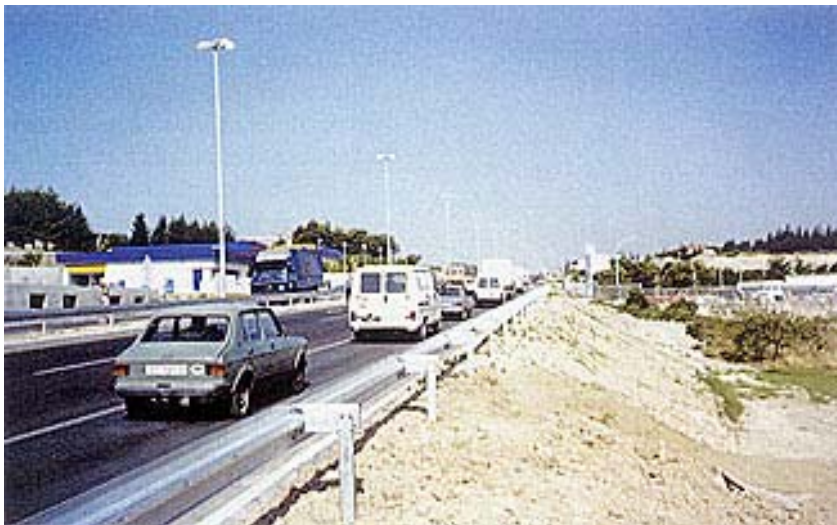
Sjeverni (novoizgrađeni) trak dijela splitske obilaznice
