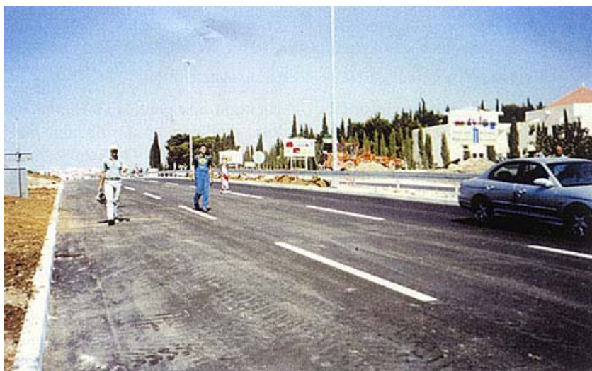
Postavljanje signalizacije na južnom traku ceste
