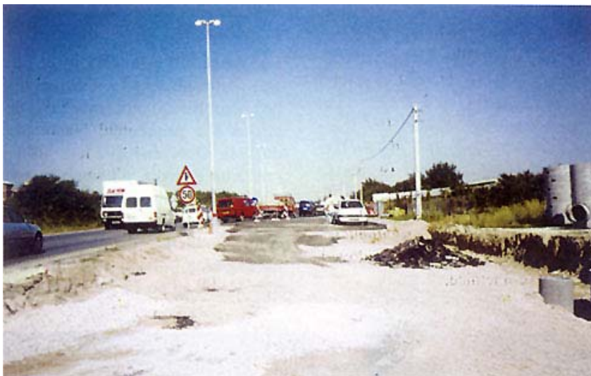
Završetak sadašnje faze izgradnje treće dionice splitske obilaznice
