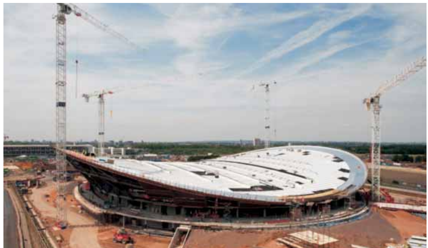
Pogled na gradilište velodroma
