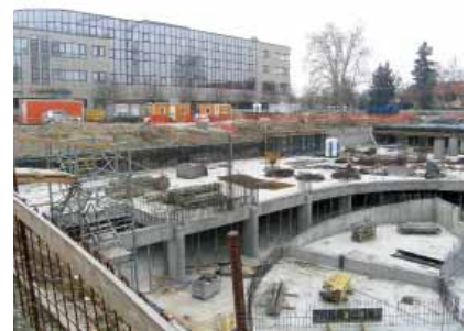
Gradilište tijekom posjeta (u pozadini zgrada Zagrebačke banke odnosno Vabe)
