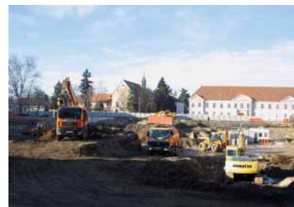
Istražni radovi u građevnoj jami
