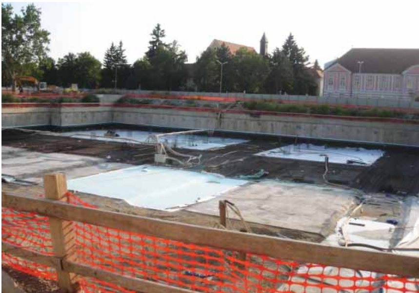
Pripreme za početak temeljenja
