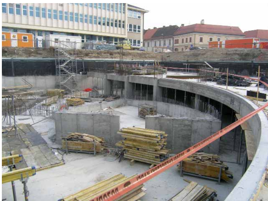
Detalj gradilišta i rampe za podzemnu garažu
