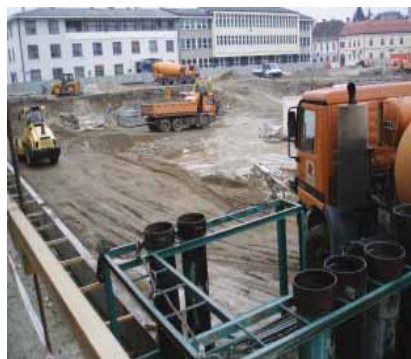
Iskop i odvoženje građevnog materijala
